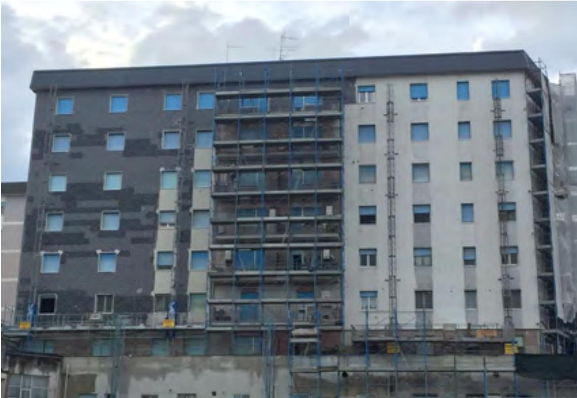
*Cantiere Ceccano (FR) – Installazione sistema di isolamento termico a cappotto*
